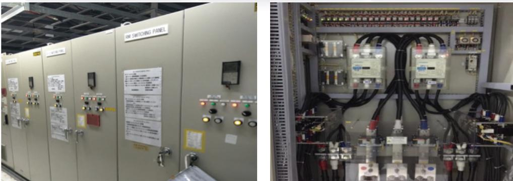
主馬達之冷卻風扇馬達安裝變頻器控制面板
