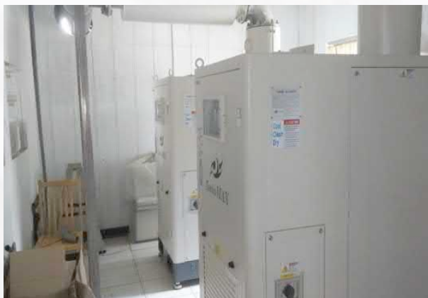
▲ 氣浮式曝氣機安裝實景及運轉狀況
