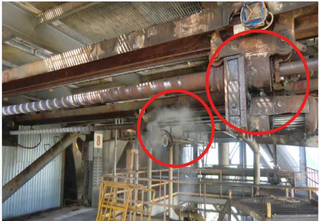
▲ RB-3 智慧型吹灰系統 (紅色圈圈) 現場輪流做動情形
