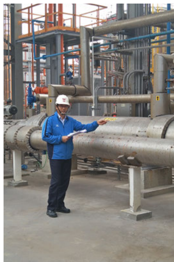
由左至右：改善 4K 蒸汽冷凝水回收設備、員工節約能源教育訓練
