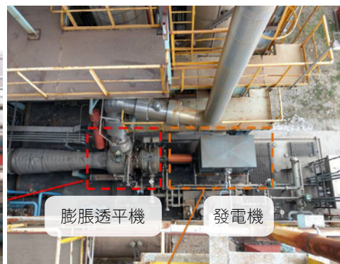
由左至右：K-6605 壓能發電機、尾氣壓能回收系統、新增膨脹透平機推動發電
