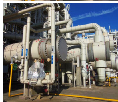
新增設兩座換熱器 E-262、E-263 與配管
