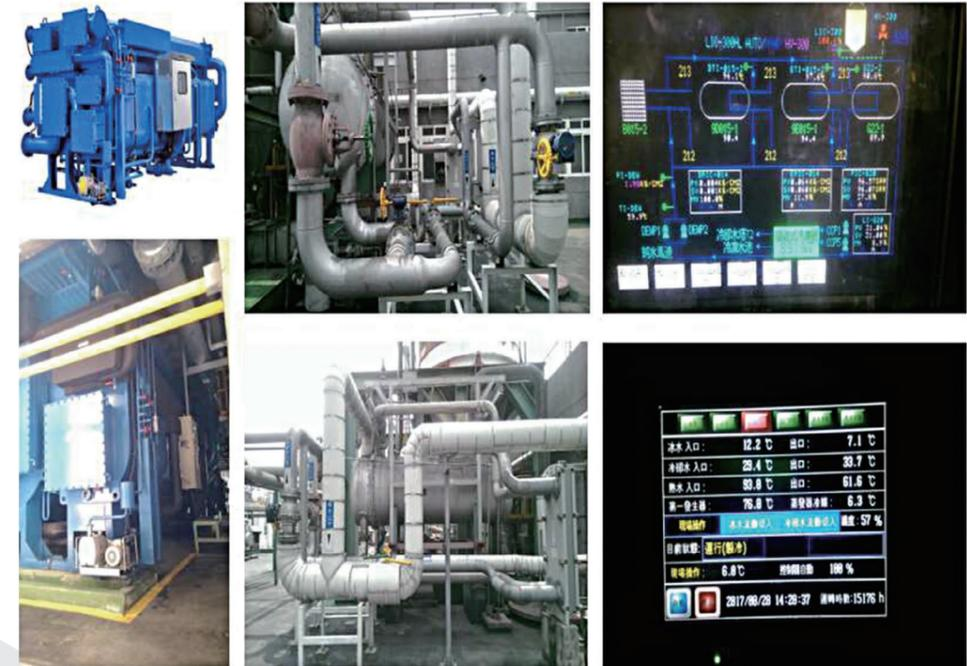
圖 4.1.3-1 吸收式冷凍機回收製程蒸餾塔之餘熱圖片
