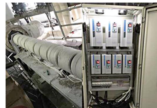
圖 3.1.3-3 電磁式加熱系統
