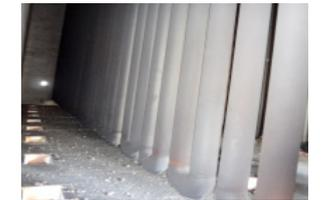
爐壁陶瓷棉脫落
