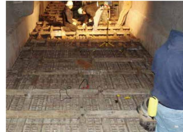
圖 4.2.2-6 冷卻爐排緊密排列
