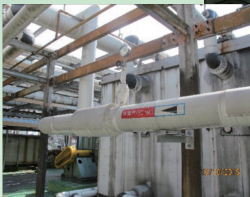
TDO補風溫18KG蒸汽冷凝水再回收使用
