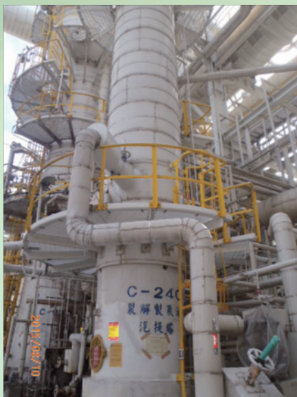
減少製氣油汽提塔C-240汽提蒸汽量
