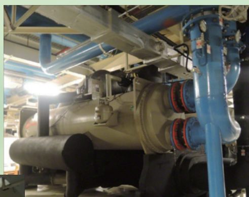
極化冷凍油-冰機效率提升：添加極化冷凍油可改善銅管表面附著狀況與回復熱傳效率
