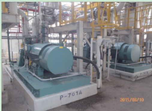
P701AB泵送量因改為C5末氫化流程而減少
