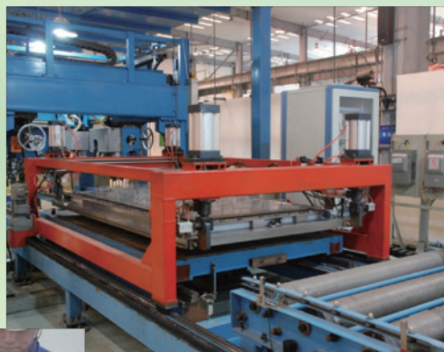
電解槽新陰極自動焊接安裝
