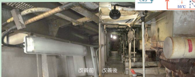
裂解爐區照明改善
