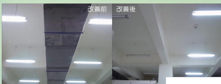
電盤室平時照明減半，人員進入再開啓
