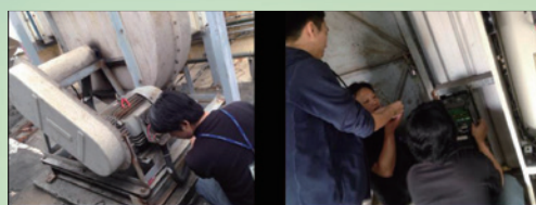
中繼抽氣風車省電節能改善工程
