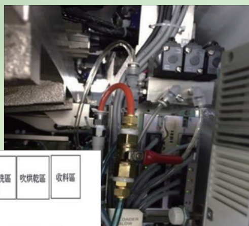
加裝管路/裝置閥門開關
