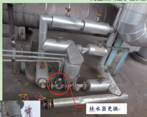
高壓蒸汽祛水器汰換
