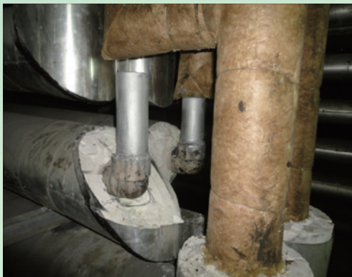
修改配管使CR1及CR2單元，共用一台熱水泵，停用一台熱水泵
