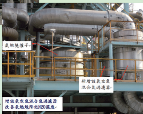
增設氨空氣混合氣過濾器改善氨燃燒降低N 2 O濃度
