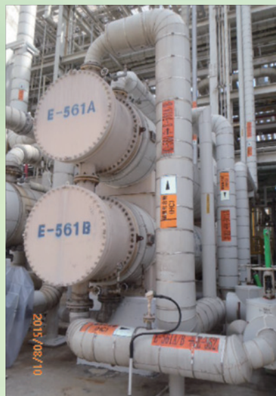
新增E-561AB減少C-720塔底再沸器蒸汽量
