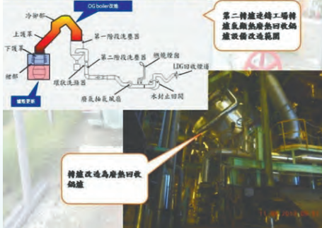
第二轉爐連鑄工場轉爐氣顯熱回收計畫(廢熱)
