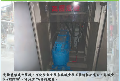
生料磨、水泥磨系統用螺旋變頻空壓機（100HP*2）更新
