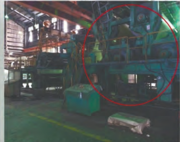
PM6 號紙機後列烘缸拆除
