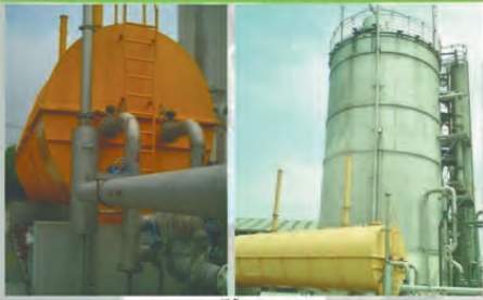
污水處理廠增設厭氧系統及沼氣回收工程
