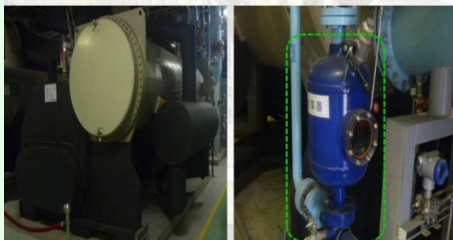
冰水主機自動清洗系統
