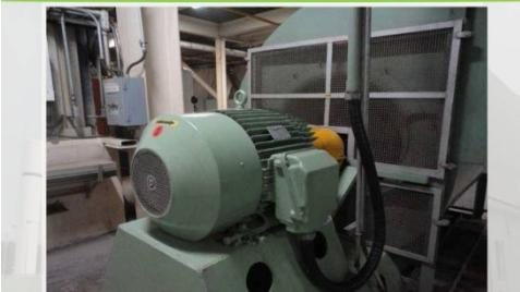
減量措施：原熔爐區主爐邊牆冷卻風車由定頻馬達改為變頻馬達，降低用電量。改善效益：節省效益為194仟元/年，可減少76噸之二氧化碳排放。
