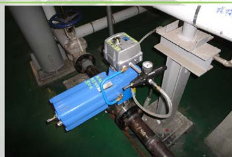
LCV2201 2"冷凝水排液控制閥太小，改為3"
