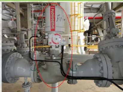
壓縮機入口處增設一加流量控制閥FV-7041
