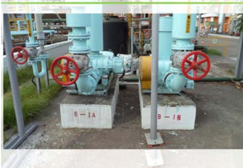
廢水場空壓機
