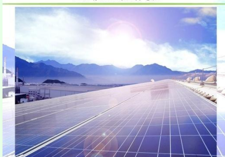
屋頂增設太陽能發電板
