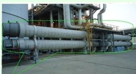
EG-4 R-520第1段進料預熱器更新：
