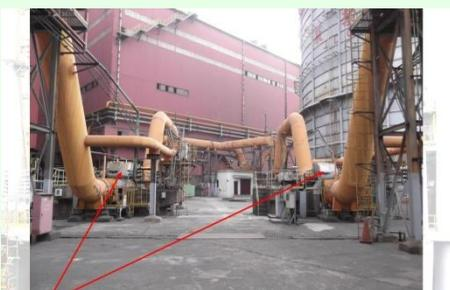
第一煉鋼轉爐氣出口增壓機依轉爐生產狀況來啟動，當轉爐3/3操作時，增壓機由現行1/2運轉改為2/2運轉。
