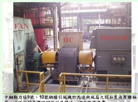
中鋼動力場9號、10號鍋爐引風機於馬達與風扇之間加裝液壓聯軸器，可於不同負載下調節風扇轉速，減少能源浪費。
