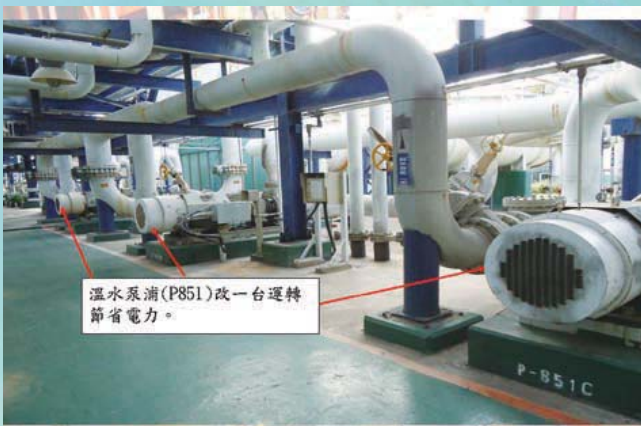
溫水系統調整系統循環流量，原溫水系統需運轉兩台溫水泵浦(P851)，經調整後改一台運轉，以節省電力耗用。
