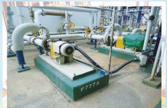
更換小馬力之馬達符合現狀實際操作運轉流量，以節省電力耗用。
