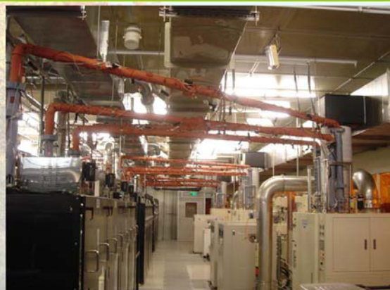
針對使用PFCs之CVD設備機台均應經過燃燒減量設施 處理後使得排放，PFCs最高去除率可達90%以上。
