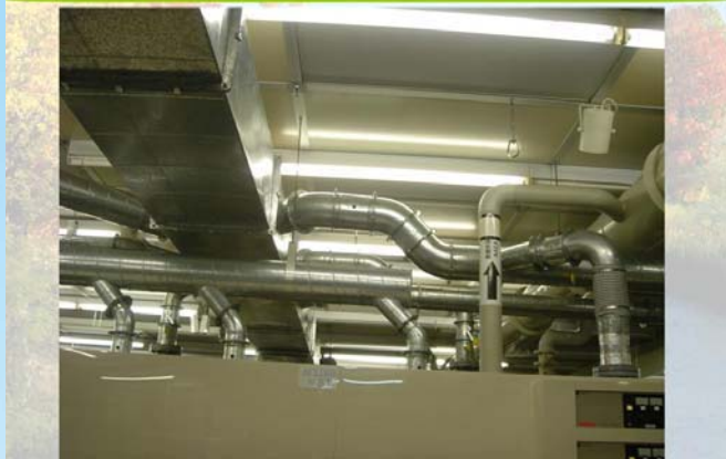
管路分流：依製程特性分別收集，區分為酸鹼排氣、有機排氣、一般排氣。
