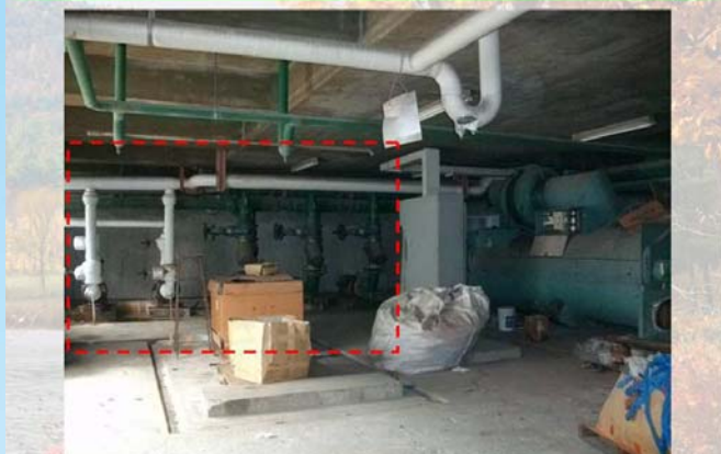
加工廠B區冰水改由主機房供應 (將A區冰水再利用配管至B區，廢除B區冰水系統運作)
