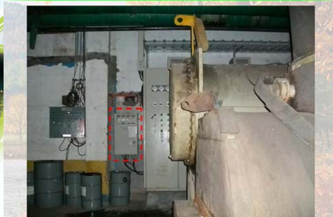
冷卻風扇加裝變頻器(以Y- \Delta 啟動改為設置變頻器)
