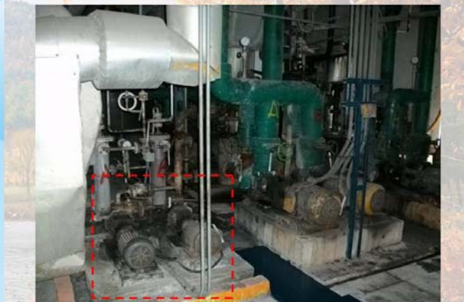
改善381 ER回收系統降低蒸氣用量(增加343-D-6設備)
