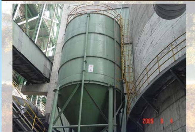
生料磨添加永豐餘底灰—事業廢棄物再利用
