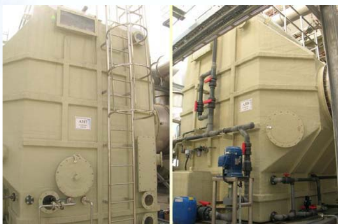
空污防制設備Central Scrubber (水洗式)，廢氣由LS燃燒處理後，再經由水洗式洗滌塔處理
