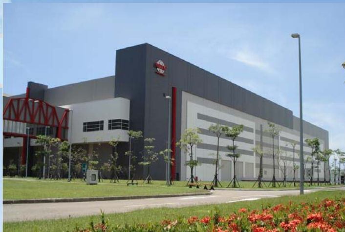
台積公司晶圓14廠第三期廠房為台灣第一座取得美國LEED黃金級綠建築認證
