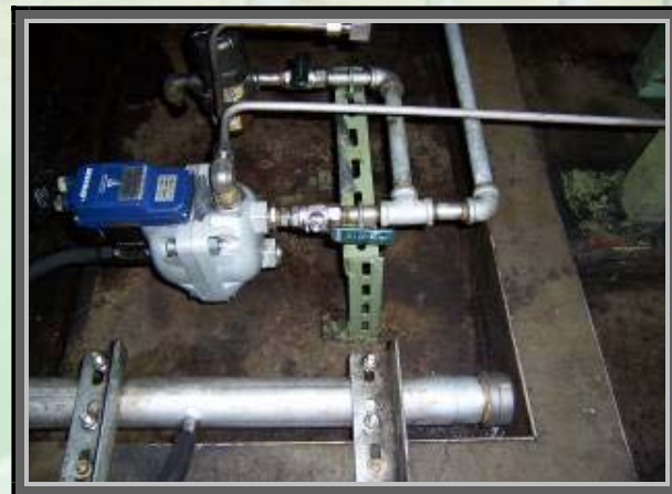
圖 2 空壓機 Trap 排水方式
