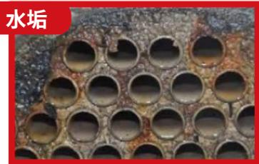
日月光導入海綿清洗球取代人工清潔，清洗球可自動監測，且每 20 分鐘跑一次循環，確實清除水垢，讓冰機大幅減少能耗又能保持最佳效能。
