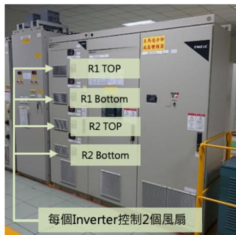
熱軋場粗軋機改良主馬達冷卻風扇及控制設備
