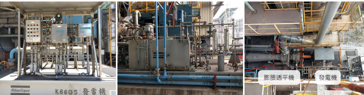
由左至右：K-6605 壓能發電機、尾氣壓能回收系統、新增膨脹透平機推動發電
