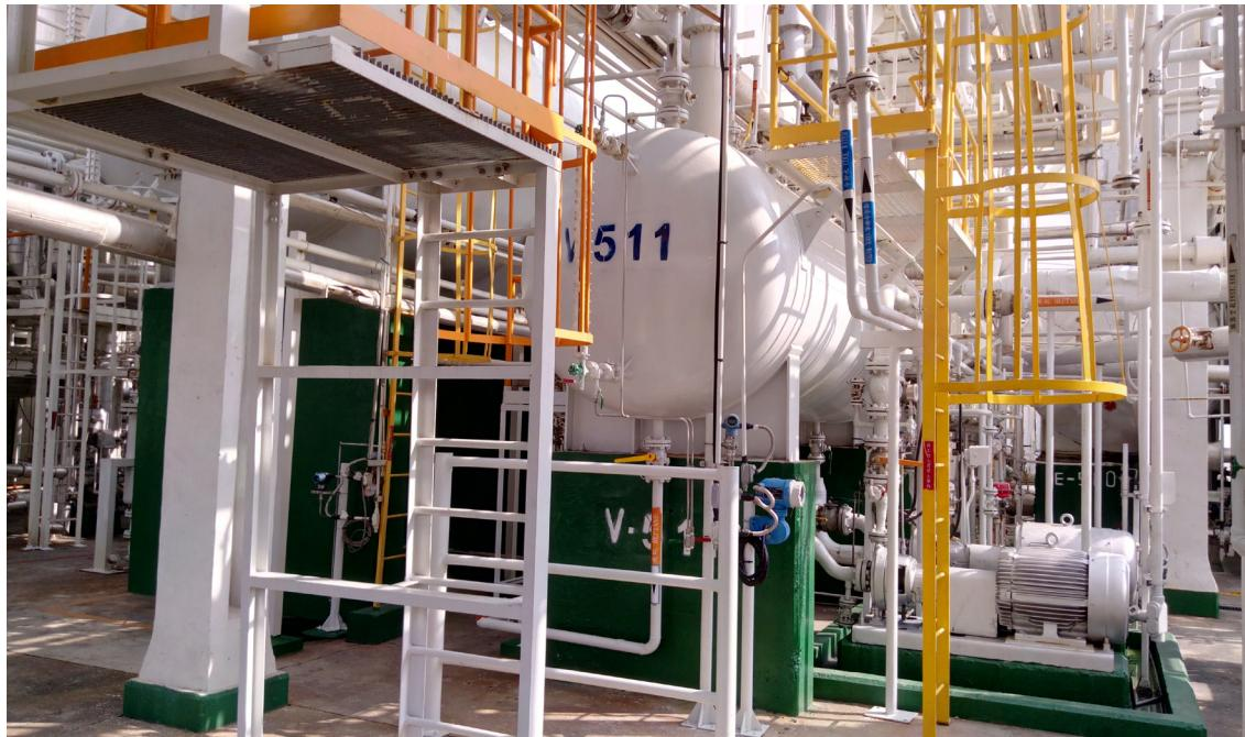
PPI 庚烷回收區泵浦沖洗液改善案，可節省蒸汽和冷卻水用量。
