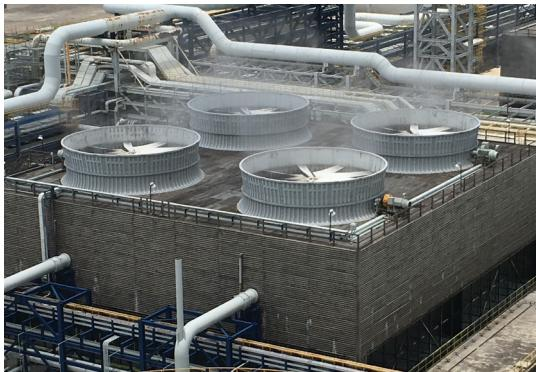
由左至右：冷卻水塔風扇改用高效率 FRP 葉片、變極馬達（4P/8P）
