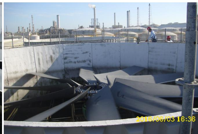
更換高效能 CFRP 葉片，節省電力。
