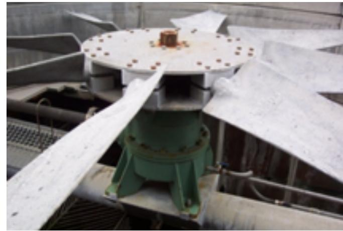
冷卻水塔原風車葉片為鋁合金材質
