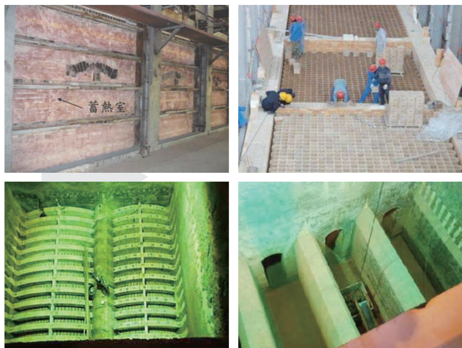
圖 4.3.2-1 建廠時即設計的蓄熱室結構照片
