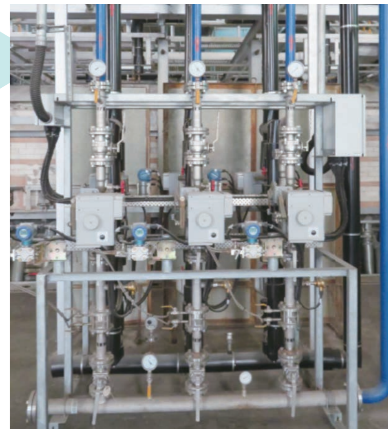
圖 4.1.1-5 改善後氧氣設備照片(b)
