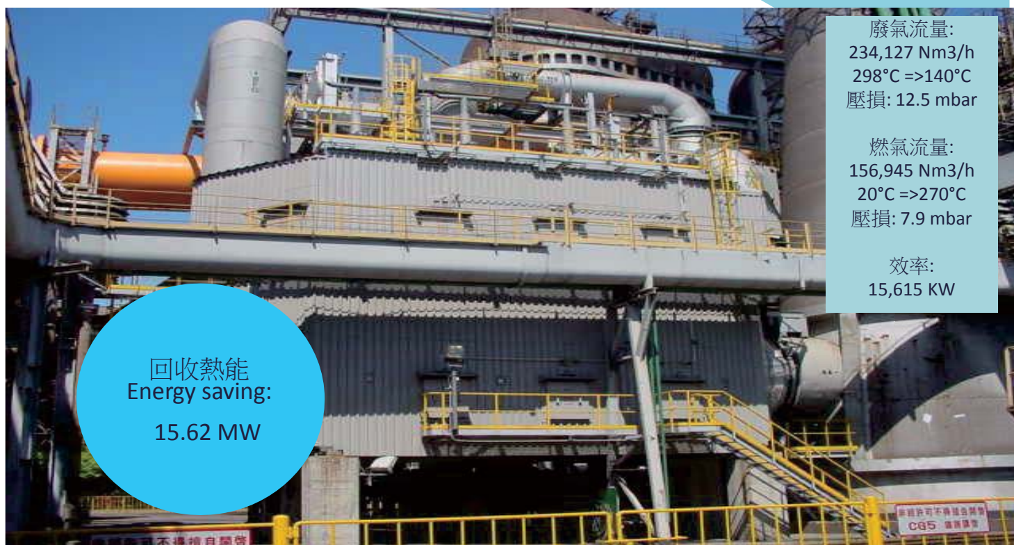
熱風爐熱管式燃氣預熱器應用 Heat Pipe BFG Preheater – Ecostat
