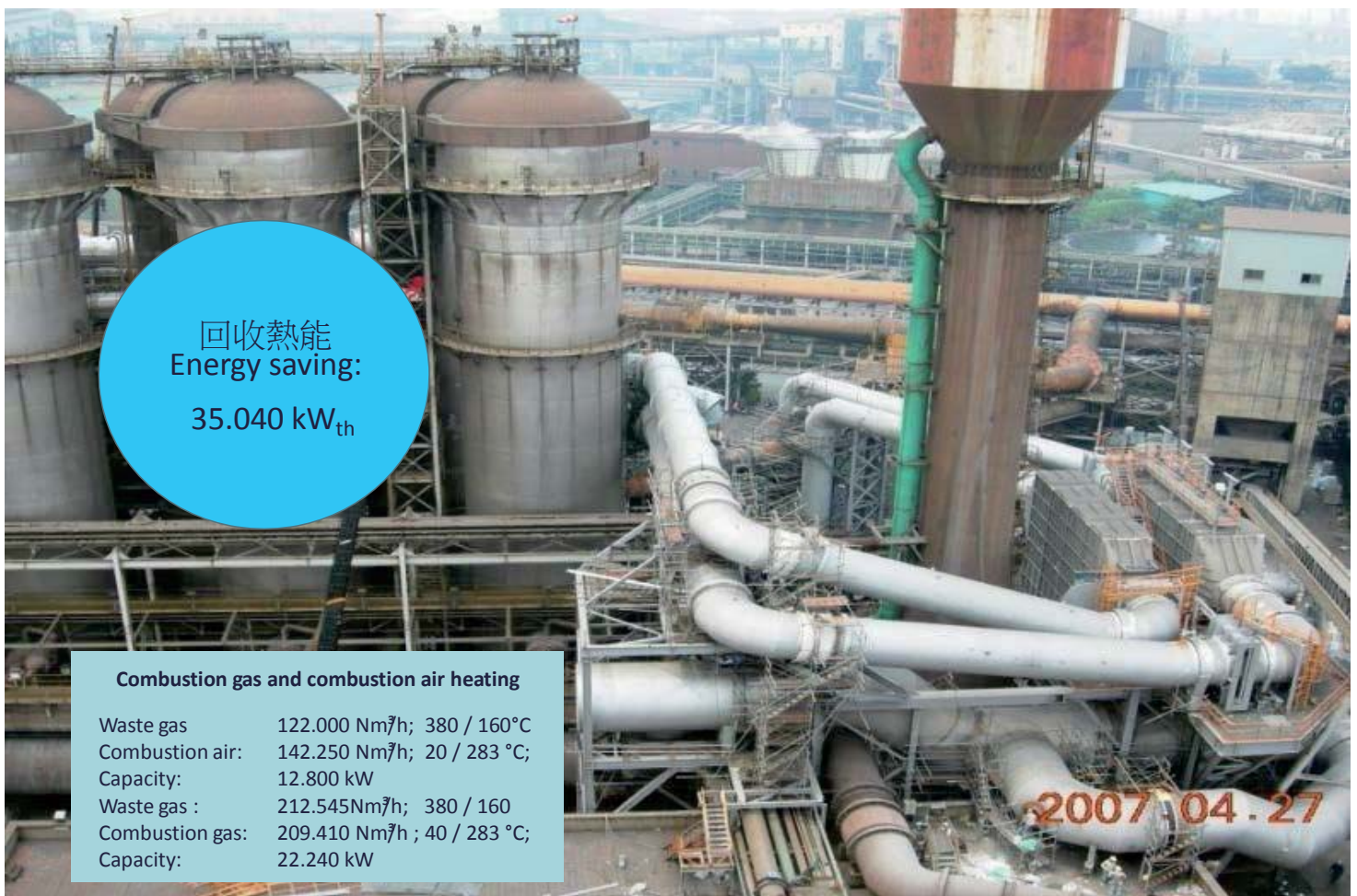
中鋼四號高爐熱管式應用範例 CSC BF4 Heat Pipe Preheater - Ecostat
