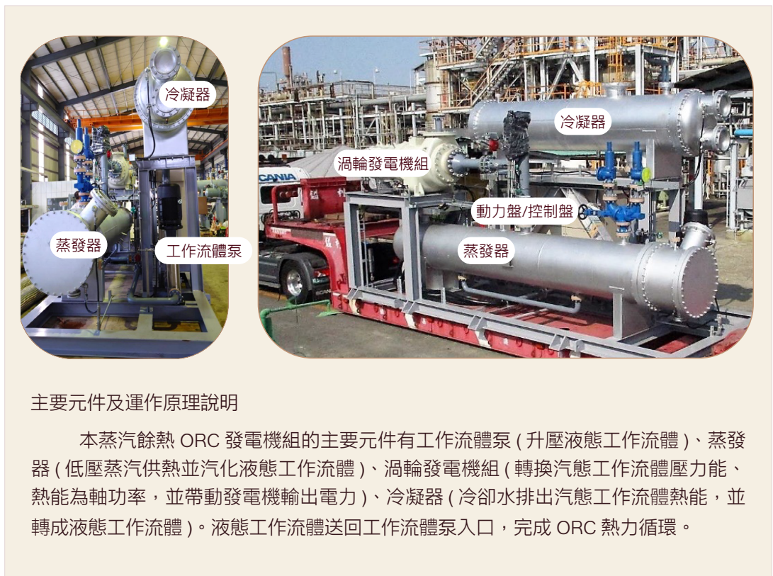
圖4.2.2-1 案例廠有機朗肯循環ORC發電技術設備圖
