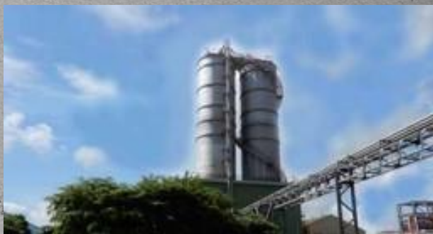
➢ 華聚公司林園廠PVC粉槽
