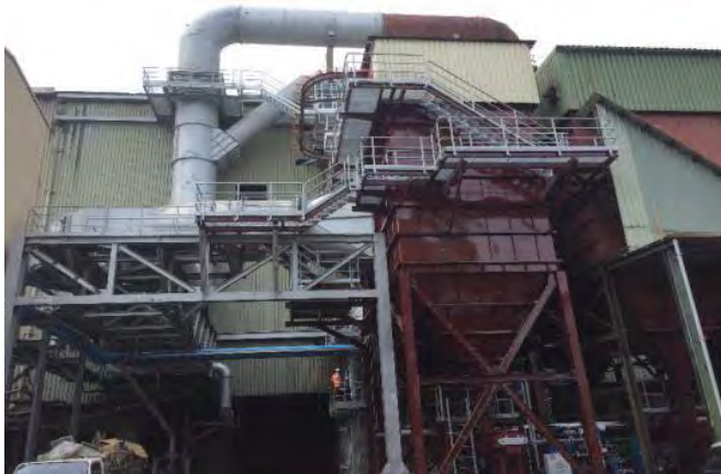
集塵管路連接施工
