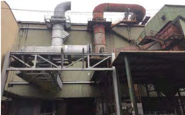
集塵管路預組立
