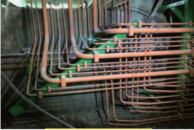
油壓配管管路之照片
