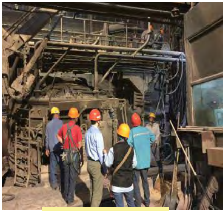
電爐爐體施工
