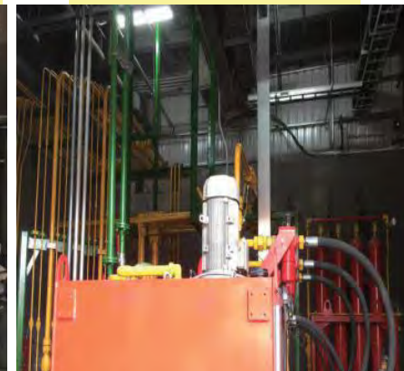
油壓設備施工一隅
