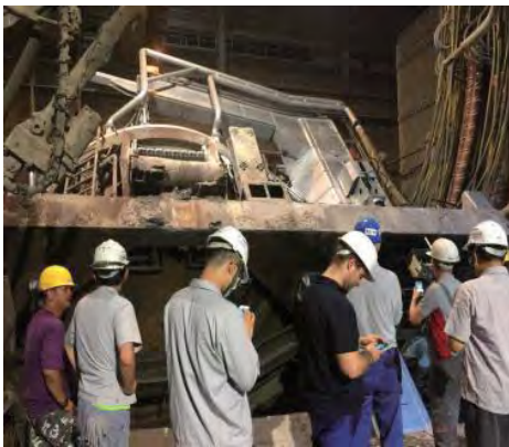
曾廠長在電爐跟催施工進度
