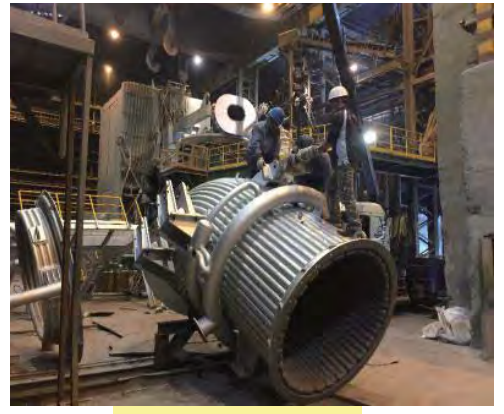
電爐爐體施工
