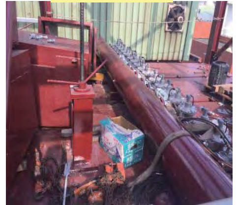
集塵設備施工
