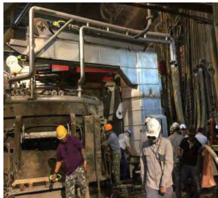
電爐爐體施工照片
