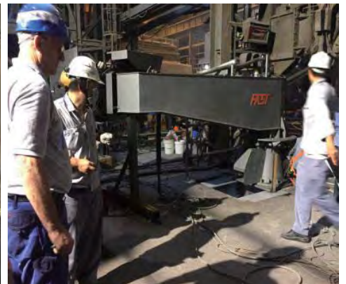
總技師在電爐指揮設備施工
