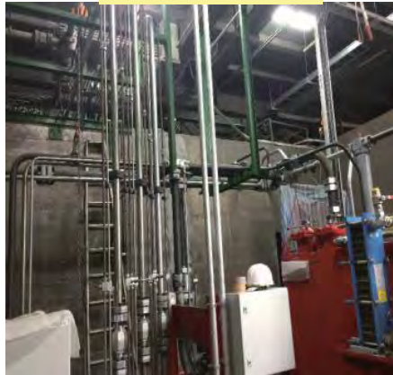
油壓設備施工
