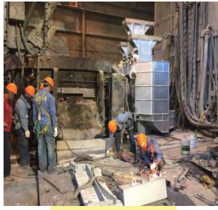
電爐爐體施工
