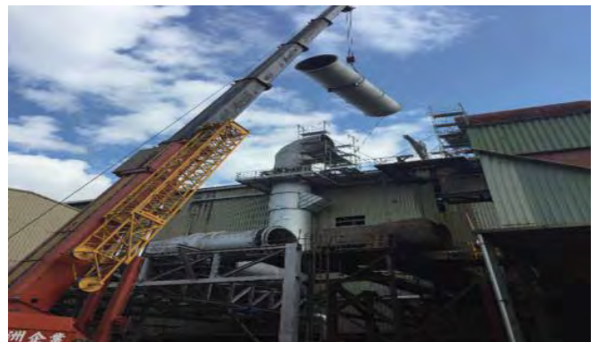
集塵管路吊裝中
