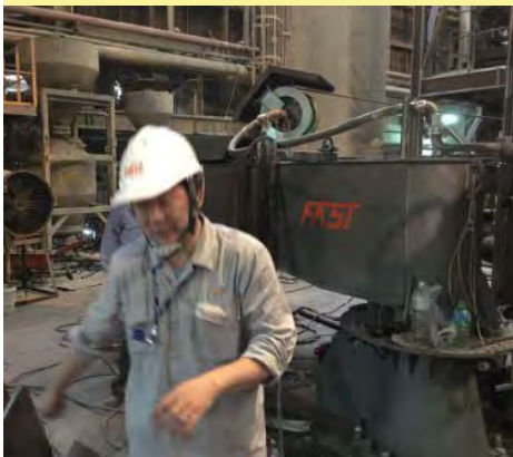
崔副理指揮吹氧槍射施工
