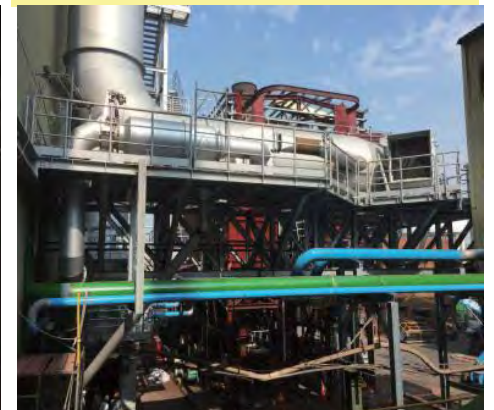
集塵設備施工完成
