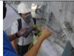
風機壓差量測
