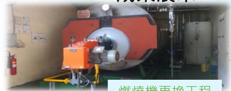
燃燒機更換工程
