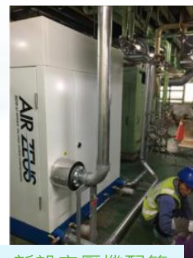
新設空壓機配管
