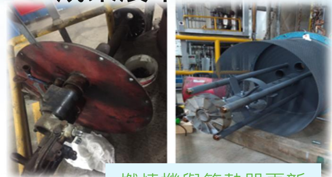
燃燒機與節熱器更新
