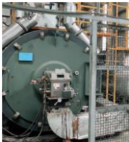
—— 150萬千卡熱媒鍋爐空氣預熱器建構
