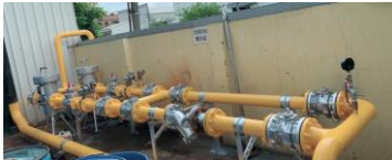
中壓管進入減壓站 ➡ 分支外內管
