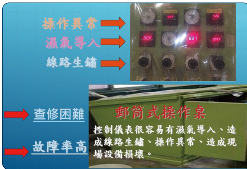
圖4.6.2-2 案例廠傳統的郵筒式操作桌面臨的維修保養問題
