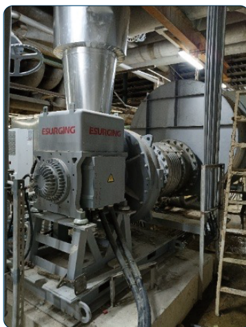
圖4.8.2.2-2 案例廠改善後紙機使用的磁懸浮透平真空泵照片
