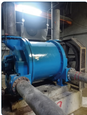
圖4.8.2.2-1 案例廠改善前紙機使用的水環式真空泵照片
