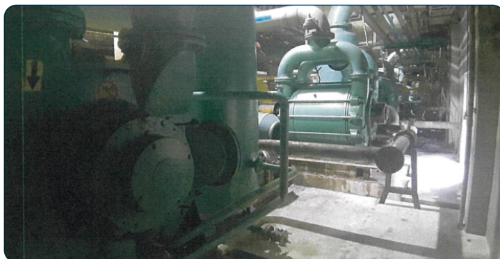
圖4.8.1.2-1 案例廠改善前#1紙機使用的8台水環式真空泵照片
