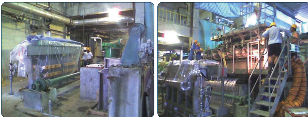
圖4.3.1-1 案例廠紙機稀釋水頭箱改造工程照片
