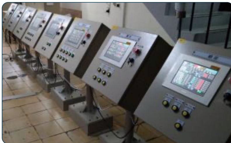
圖4.6.2-4 案例廠立柱式斜面設計操作桌
