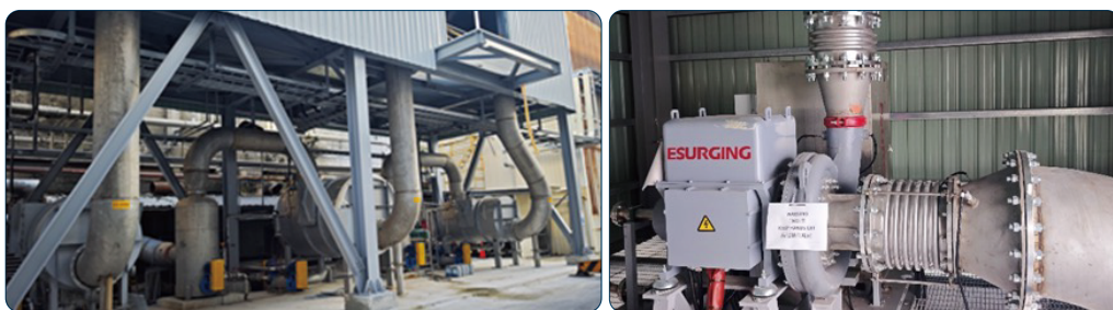
圖4.8.1.2-3 案例廠改善後#1紙機3台磁懸浮透平機照片
