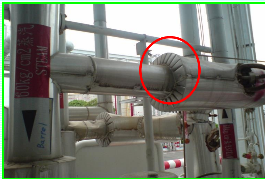
管路法蘭銜接處，保溫不良， 外表溫度 68.2^{\circ}\text{C}
