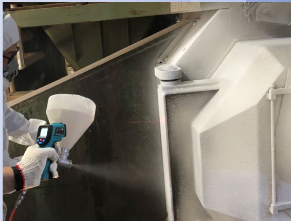
塗料以一層一層堆疊方式噴佈 厚度至所要求的表面溫度
