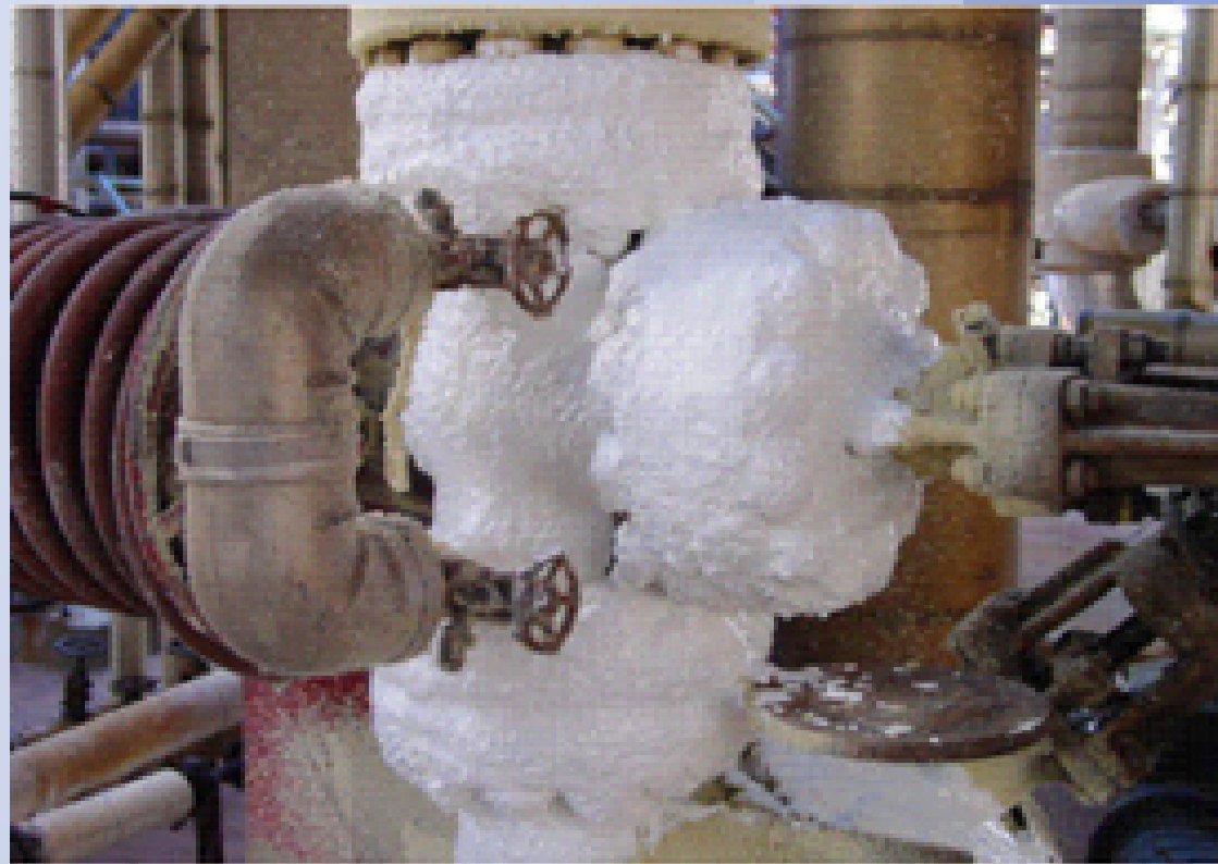
在閥門處直接塗裝綠能HIC陶瓷 保溫塗料，不需停機。
