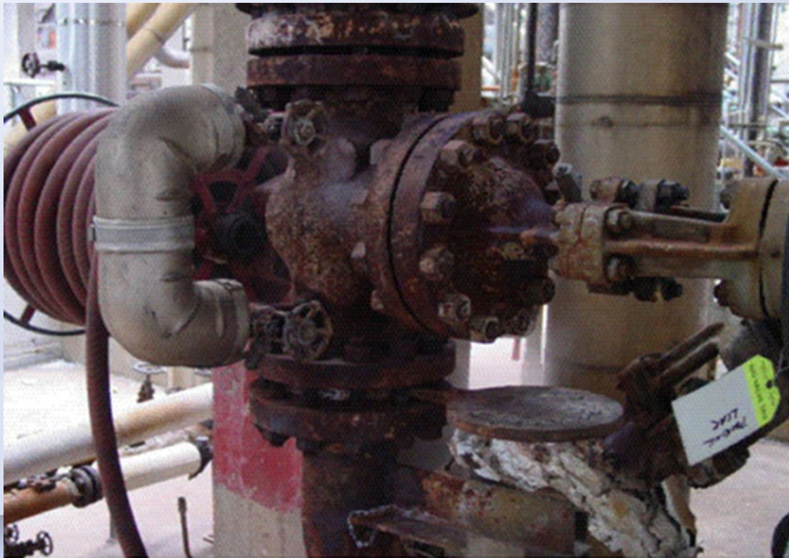
未塗裝處理的蒸氣閥門 溫度240°C
